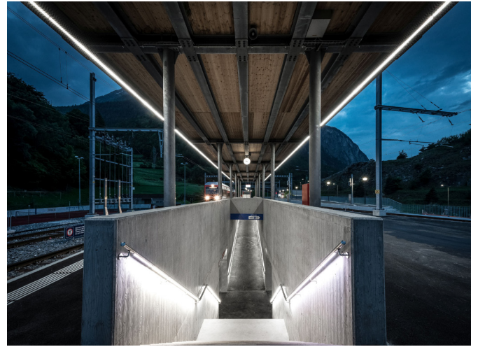
Bahnhof Sembrancher (Decke: LaneLED WALL, Treppenabgang: LaneLED INOX42)
